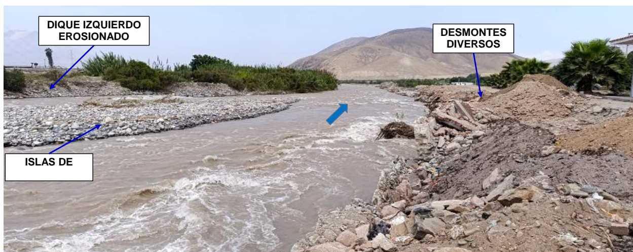
FIGURA N°03: RIO CHANCAY HUARAL, CON EL CAUCE COLMATADO CON SEDIMENTOS Y CON EL DIQUE EROSIONADOS EN LA MARGEN IZQUIERDA Y EN LA MARGEN DERECHA OCUPADO POR UNA CASA, PLANTAS, MONTICULOS DE TIERRA Y DESMORTE DE CONSTRUCCIÓN CIVIL.
