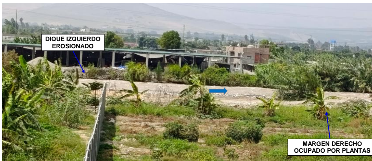
FIGURA N°04: RIO CHANCAY HUARAL, CON EL DIQUE IZQUIERDO CONFORMADO POR MATERIAL PROPIO CON EROSION AVANZADA, POR DETRAS SE ENCUENTRA CONSTRUCCIONES RURALES Y VIVIENDAS.
