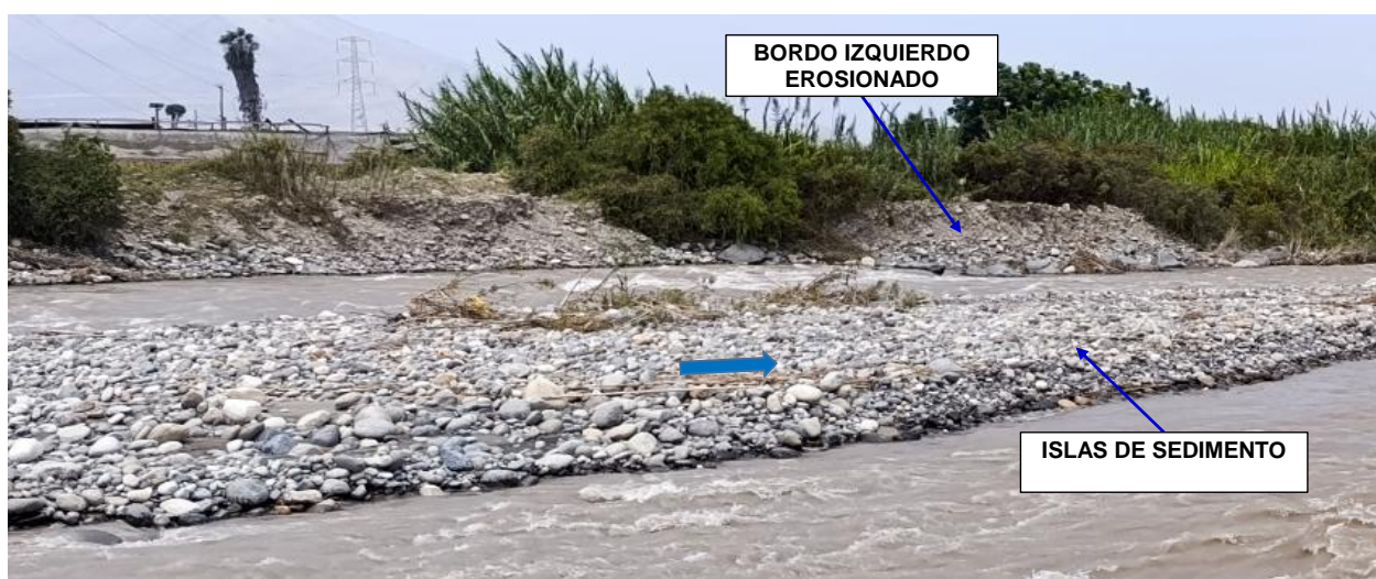
FIGURA N°02: RIO CHANCAY HUARAL, SECTOR PASAMAYO ALTO CON EL CAUCE COLMATADO E ISLAS DE SEDIMENTOS QUE DESVIA EL CAUDAL DEL RIO HACIA LOS DIQUES DE AMBOS MARGENES QUE ESTA EROSIONANDO PRINCIPALMENTE EN LA MARGEN
