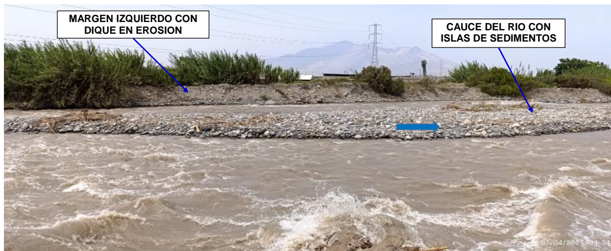
FIGURA N°01: TRAMO CRÍTICO EN EL RÍO CHANCAY HUARAL MARGEN IZQUIERDO, SECTOR PASAMAYO ALTO, CON EL DIQUE CONFORMADO POR MATERIAL PROPIO EN EROSIÓN.
